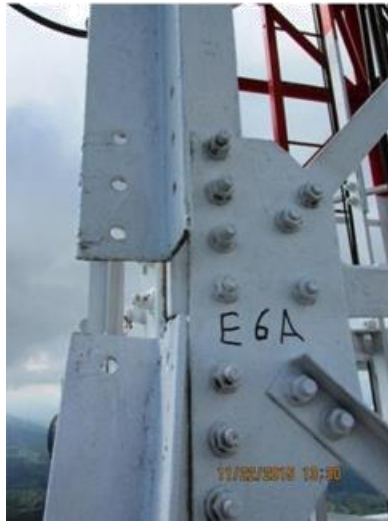
Foto 3. Unión Cuello – Nivel 28.0m (El refuerzo esta suelto)
